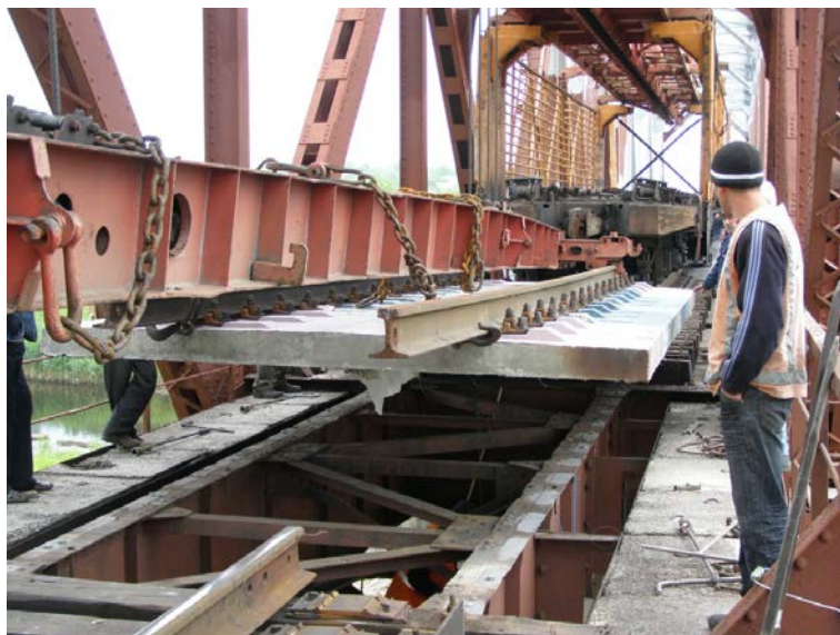
Рис. 1 – Укладання мостового полотна на безбаластних мостових плитах
