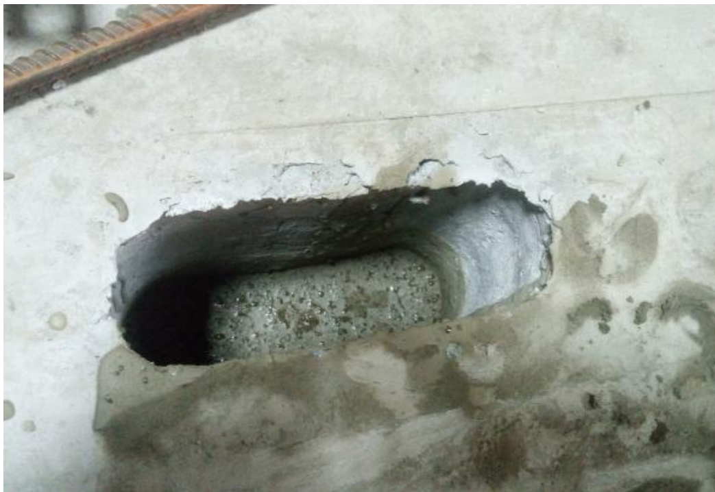
Рис. 6 – Заливка під плиту типу БМП-КР, через отвори для шпильок, швидкотвердіючої безсадочної суміші
